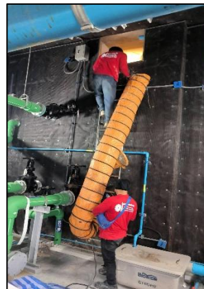
ภาพที่ 10 ทำความสะอาดถังเก็บน้ำ
